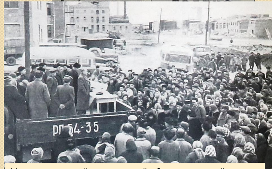
Митинг строителей, посвященный объявлению стройки Волгодонского комбината комсомольской стройкой (фото из книги «Юность в пути», Рост. Книж. Издат-во, 1968г.)
