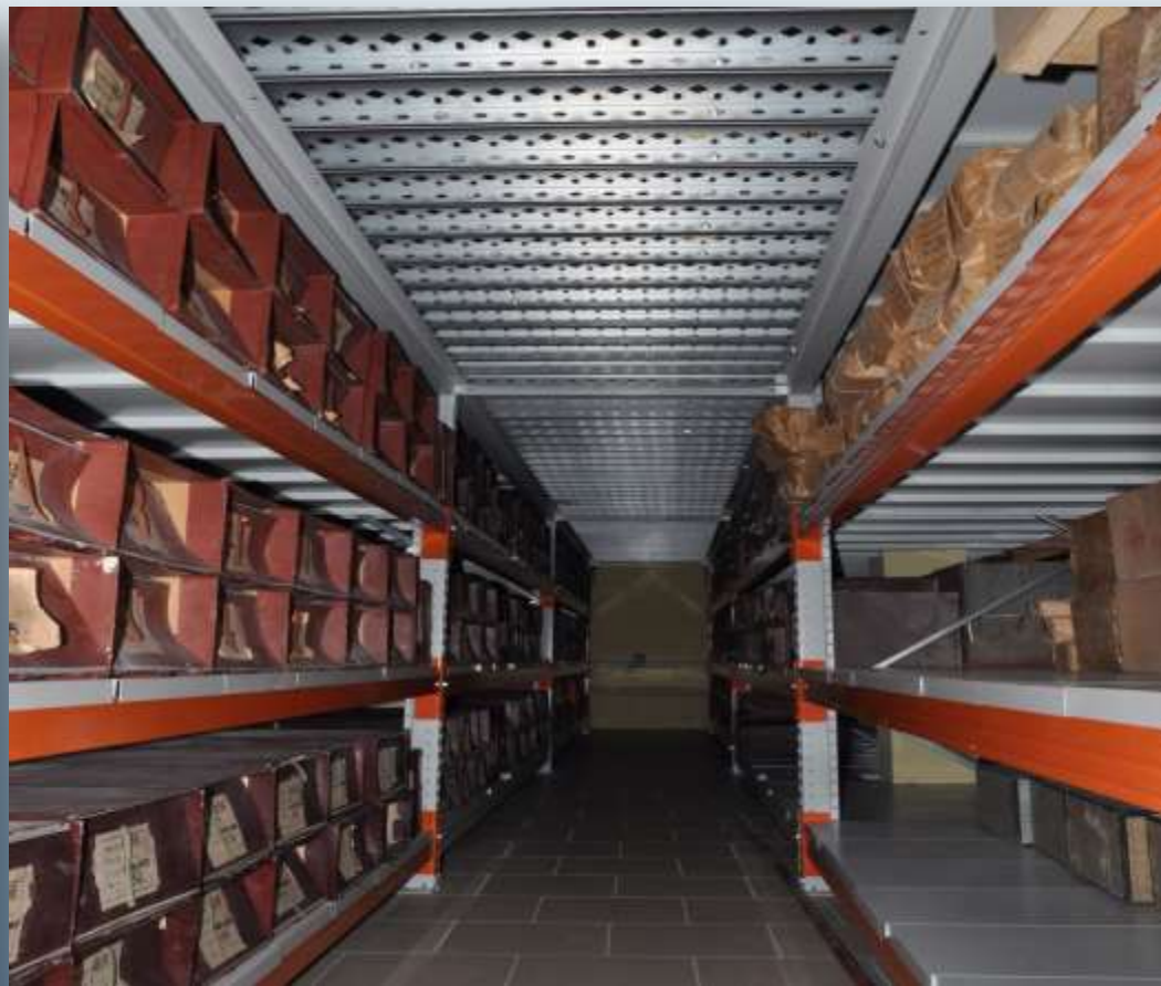
Архивохранилище ГАРО после завершения ремонтных работ и установке новых стеллажей
