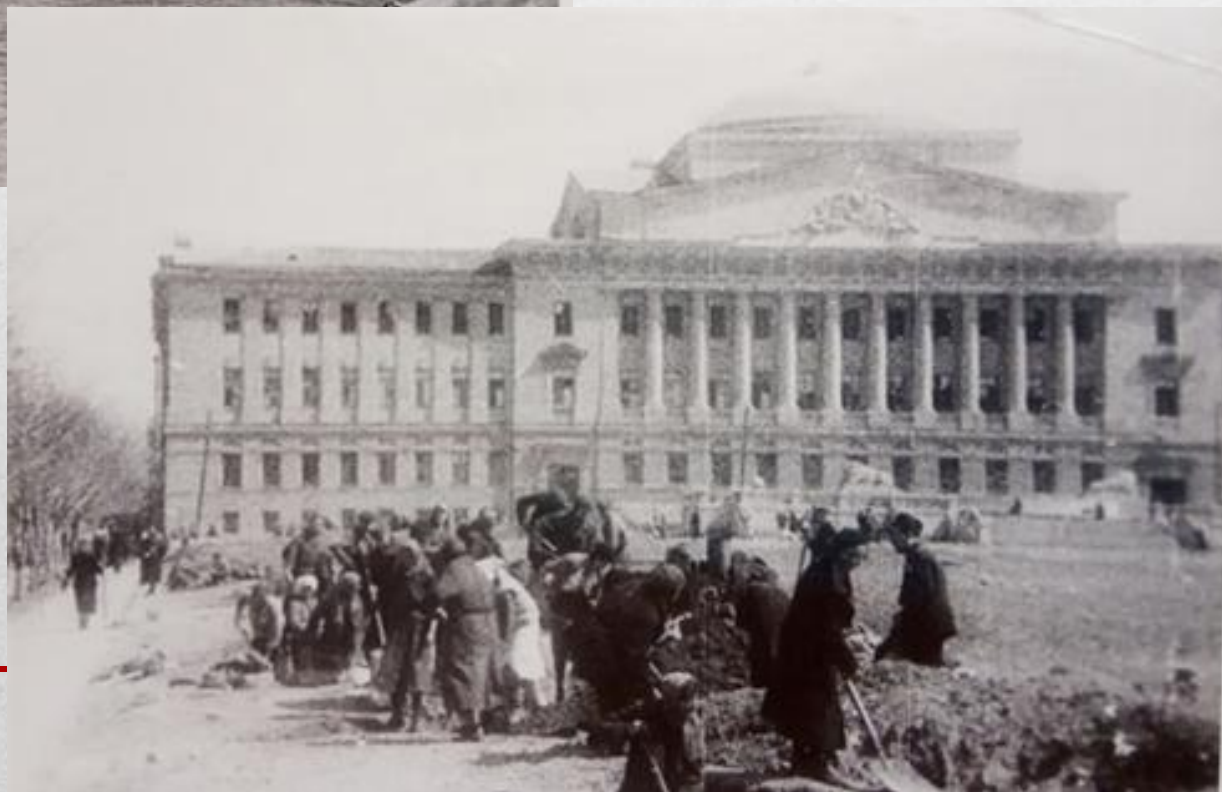
Строительство оборонительных сооружений в Ростове-на-Дону. ГАРО. Фотокаталог.
