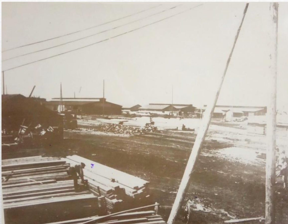
Панорама строительства завода Ростсельмаш.
