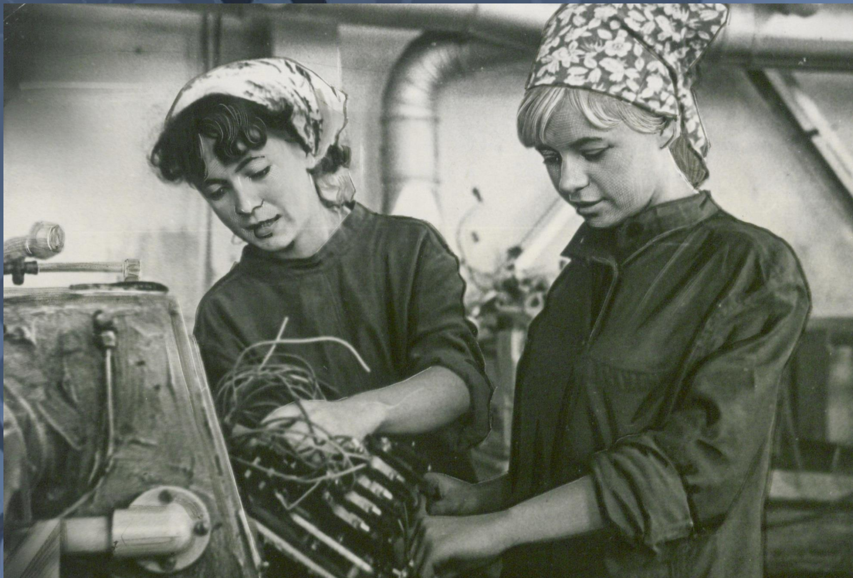
Ольга и Тамара Крюковы – лучшие электромонтажницы Новочеркасского станкостроительного завода (1969). ЦДНРО. Ф.Р-3619. Оп.6. Д.380
