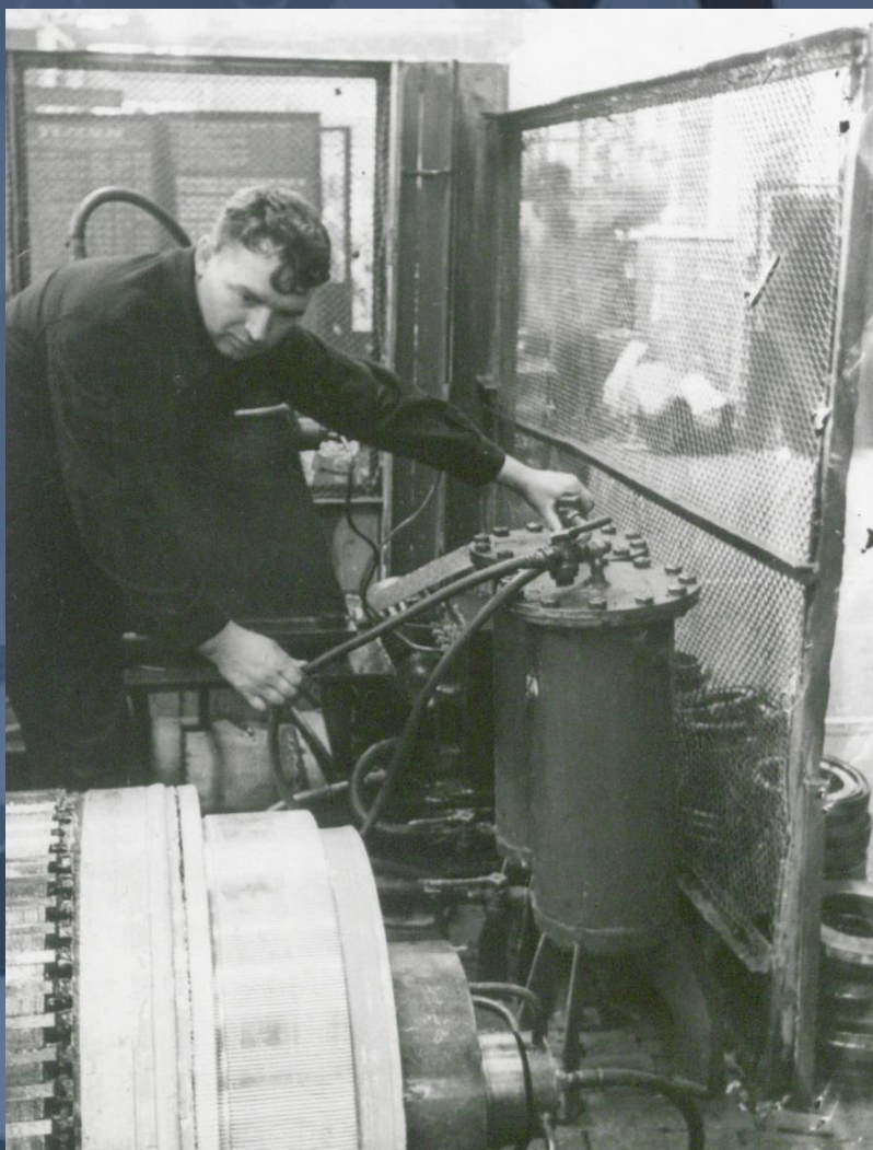
Бригадир Новочеркасского электровозостроительного завода Дмитрий Маринич монтирует подшипники на якорь движения (1963).
