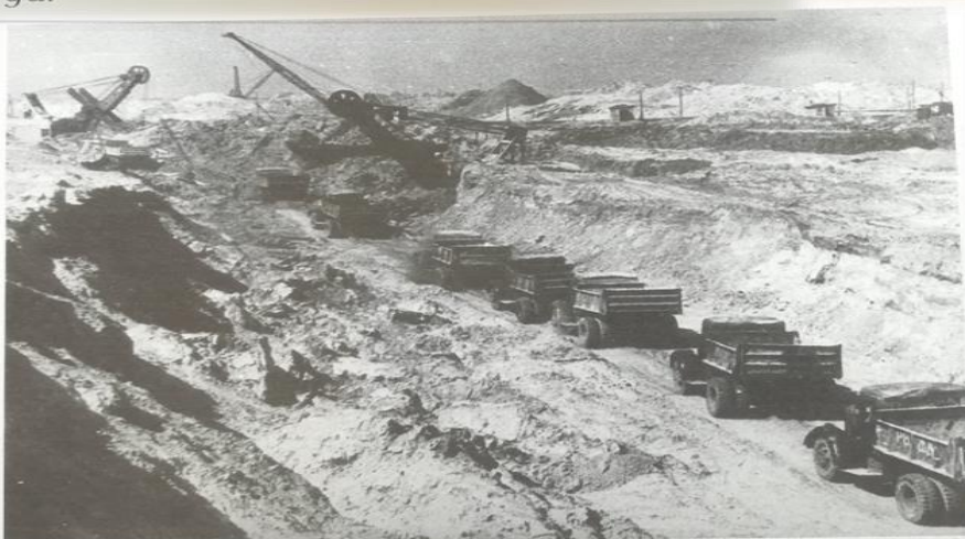
Техника на строительстве трассы будущего канала. 1950 год.
