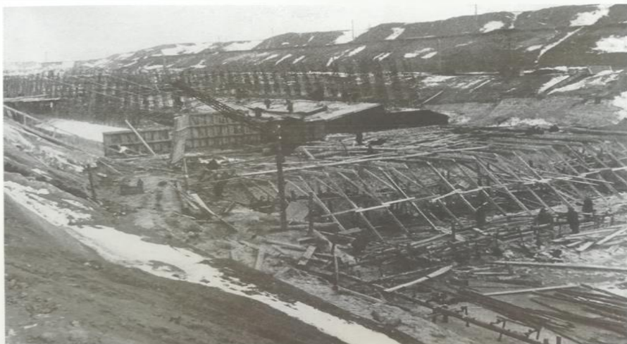
Начало строительства шлюза №15. Начало 1950 года.
