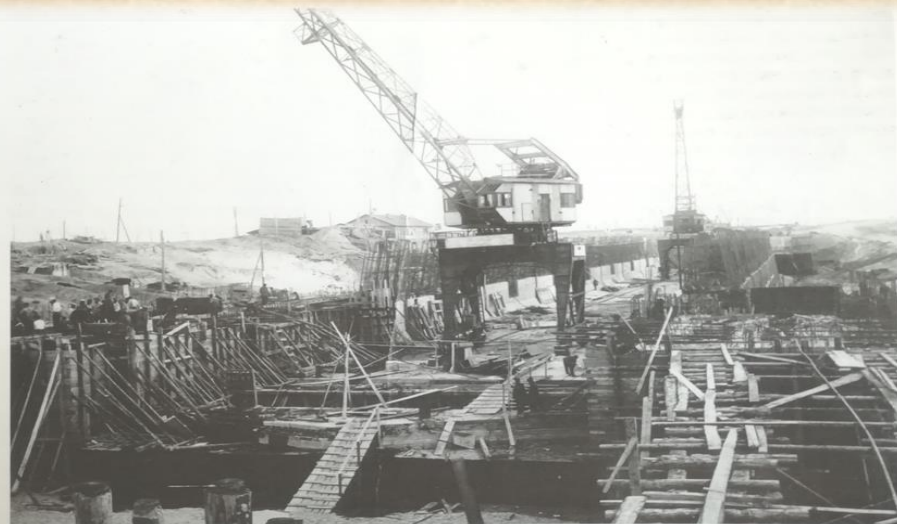
Строительство камеры шлюза №15 судоходного канала. 1950 год.
