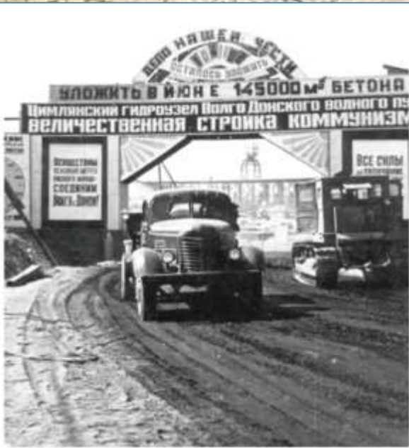
Выезд на строительную площадку Цимлянского гидроузла
