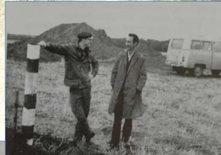
Первый кольшек на строительстве ВЗТМ. Справа – главный инженер будущего завода Ю.Н. Зорин. Декабрь 1972 года.
