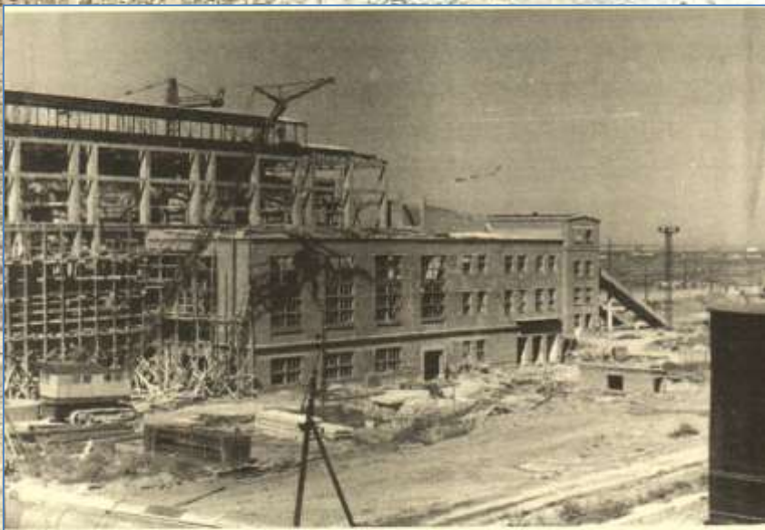
Строительство Волгодонского комбината синтетических жирозаменителей. 1956 год.
