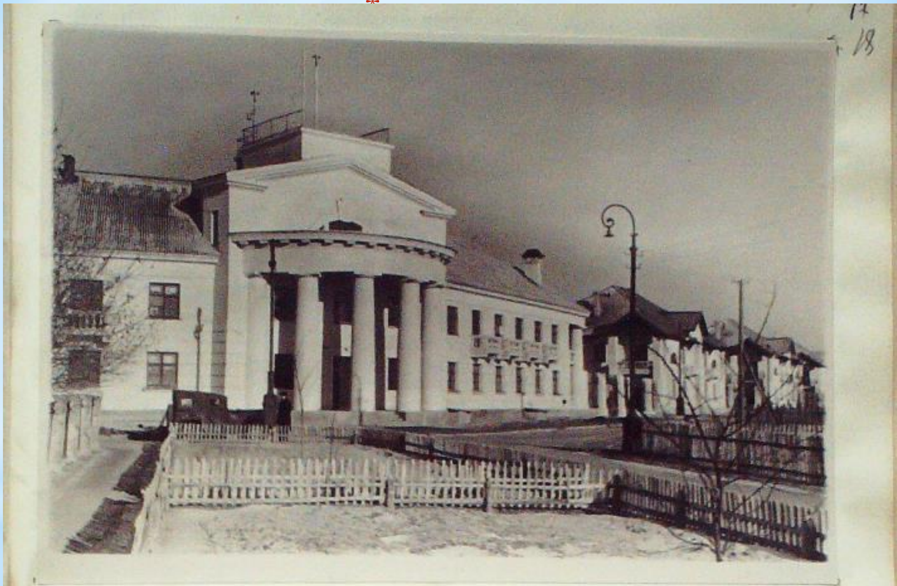
Здание Обсерватории в пос. Цимлянской ГЭС.
