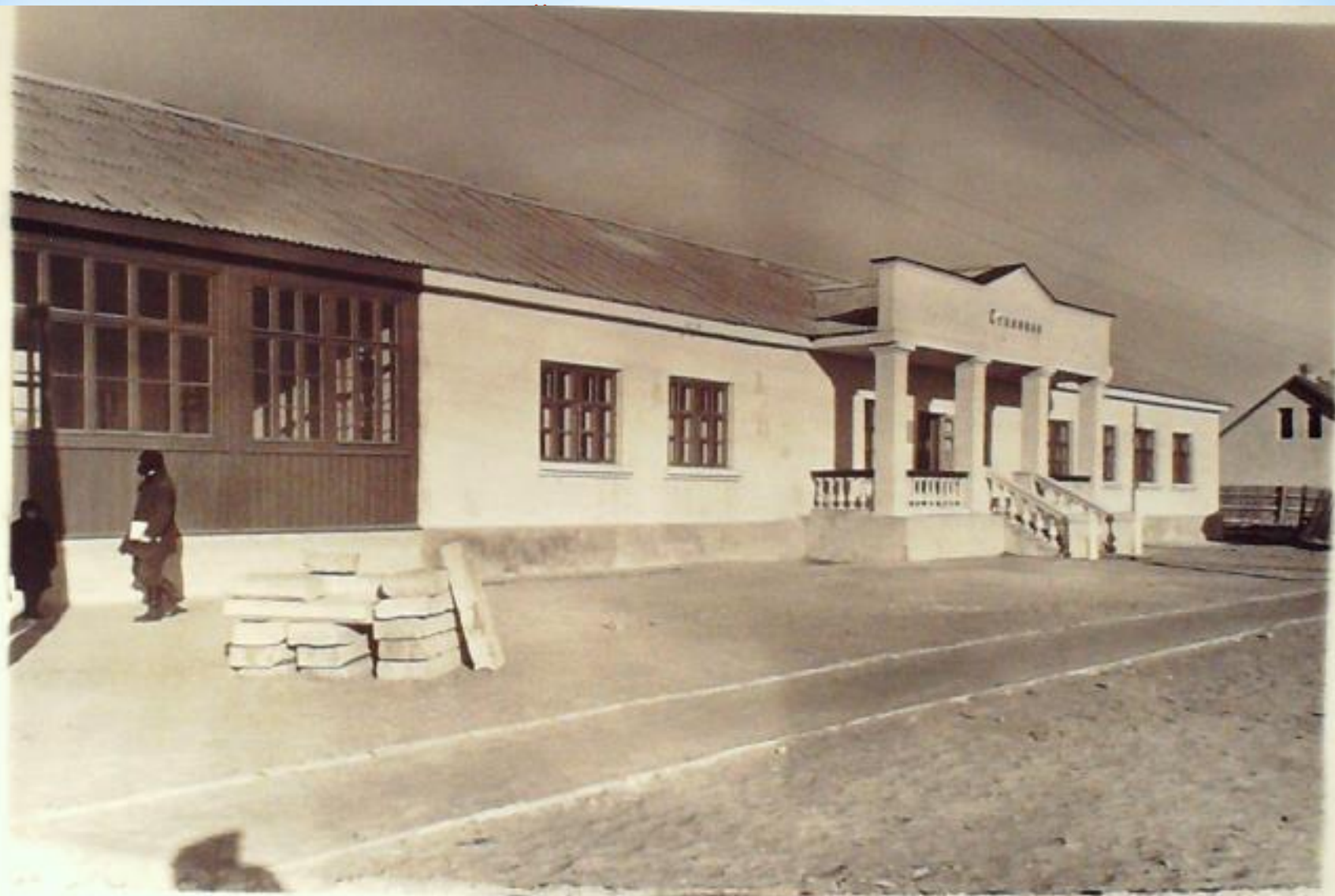
Здание столовой № 3 в пос. Цимлянской ГЭС, сданное в эксплуатацию после капитального ремонта.
