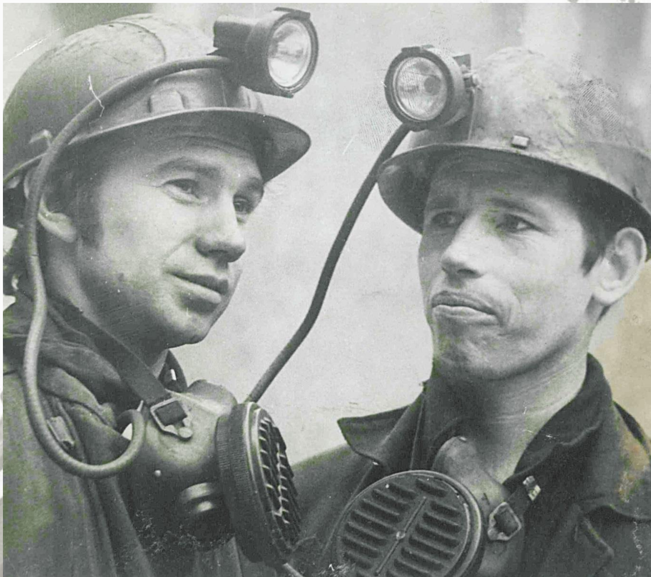
Кононенко Леонид, Качкин Михаил-электрослесари шахты «Глубокая». г. Шахты. Дата съемки неизвестна.
