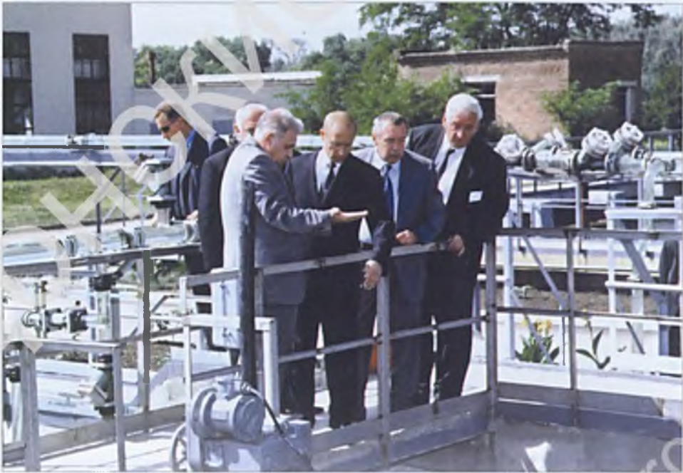
Посещение Президентом России В.В. Путиным очистных сооружений. г. Ростова-на-Дону. 3 сентября 2003 г.
