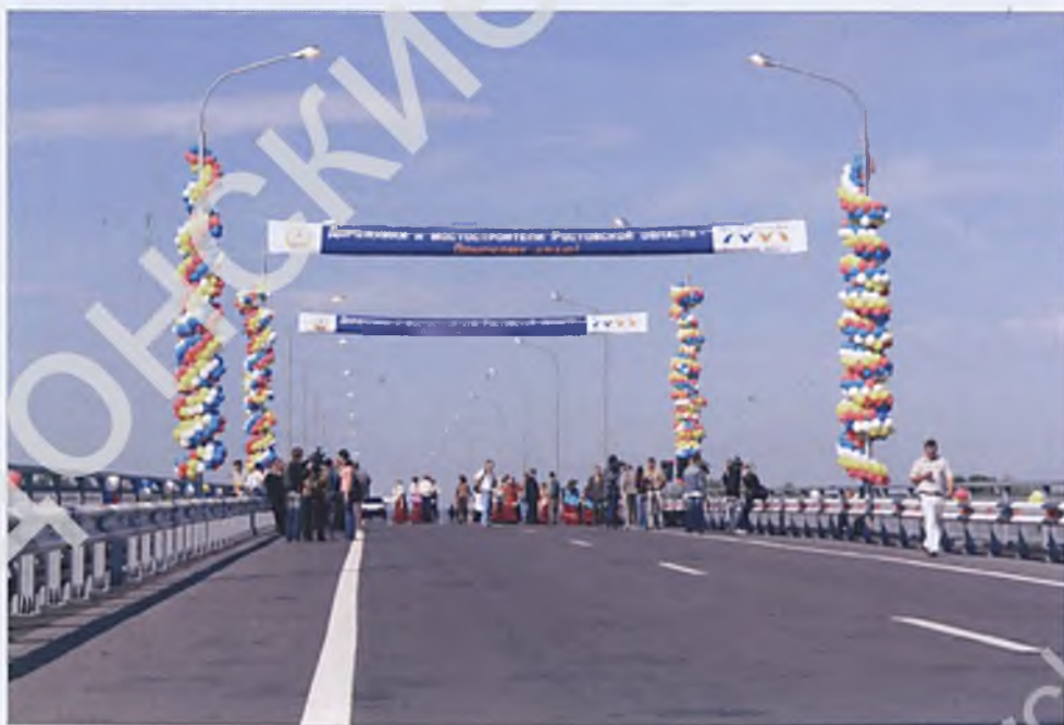
Открытие автомобильного моста через р. Северский Донец. г. Каменск-Шахтинский. 26 сентября 2006 г.
