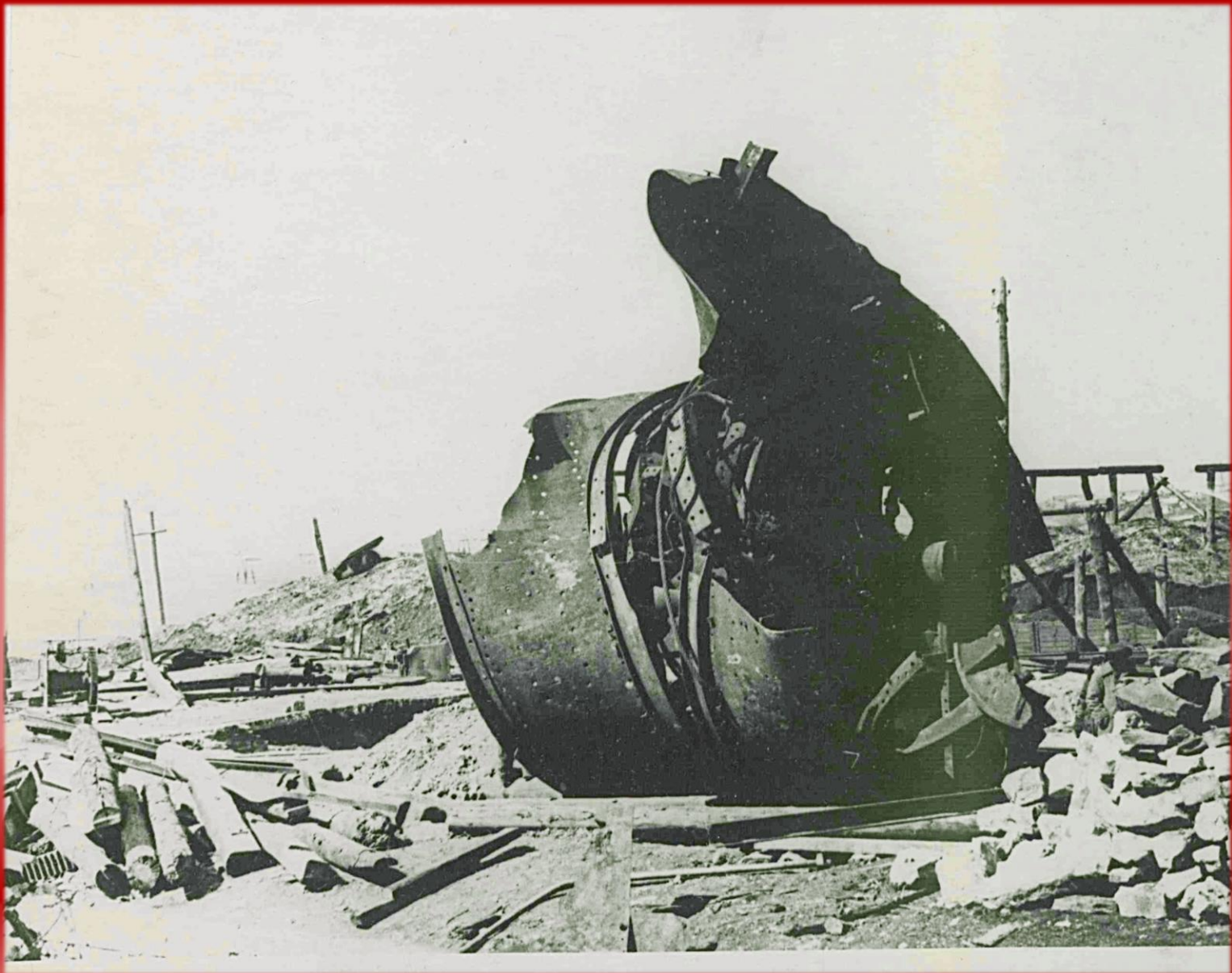
Разрушенная шахта «Комсомольская правда» треста «Шахтантрацит» комбината «Ростовуголь». г. Шахты. 1943 г. (Фонд Р-1045, Описание 8, Дело 303)
